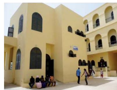
Service d'accueil et d'urgences de l'hôpital de St-Louis
